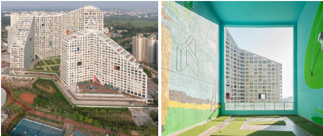
印度浦那“未来之塔”和塔内对居民开放的彩色“洞穴”。MVRDV在印度浦那的项目“未来之塔”是一座容纳了1068套公寓的巨型建筑。在安排完要求的单元数后，公寓内置入了多样性的公共功能：倾斜的屋顶提供了每层都能享受阳光的露天平台；立面上安置了一些敞开的“洞穴”。这些露台是邻里相聚、活动的空间，增添了“楼内共享”属性。
